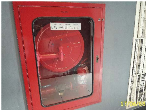
ตู้เก็บสายฉีdnน้ำดับเพลิง
